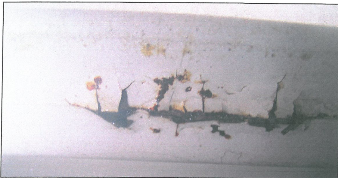
Rys. 6. Korozja podpowłokowa na belce nośnej w górnej części hali.
