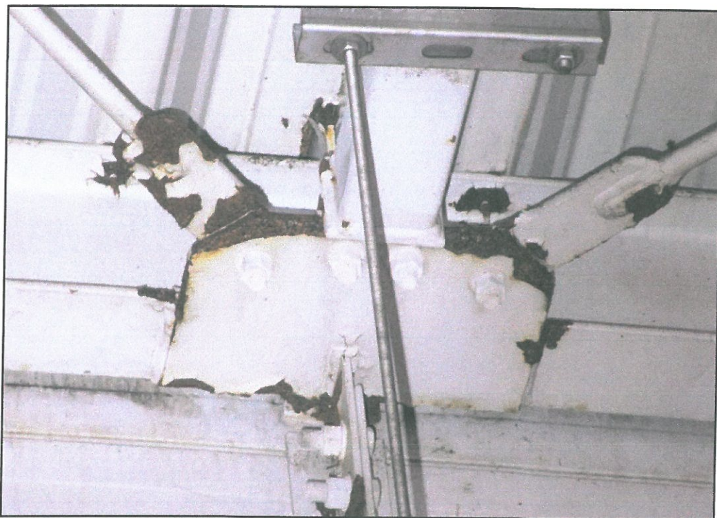
Rys.7. Korozja na połączeniach stężeń połaciowych (dachowych) konstrukcji nośnej hali.
