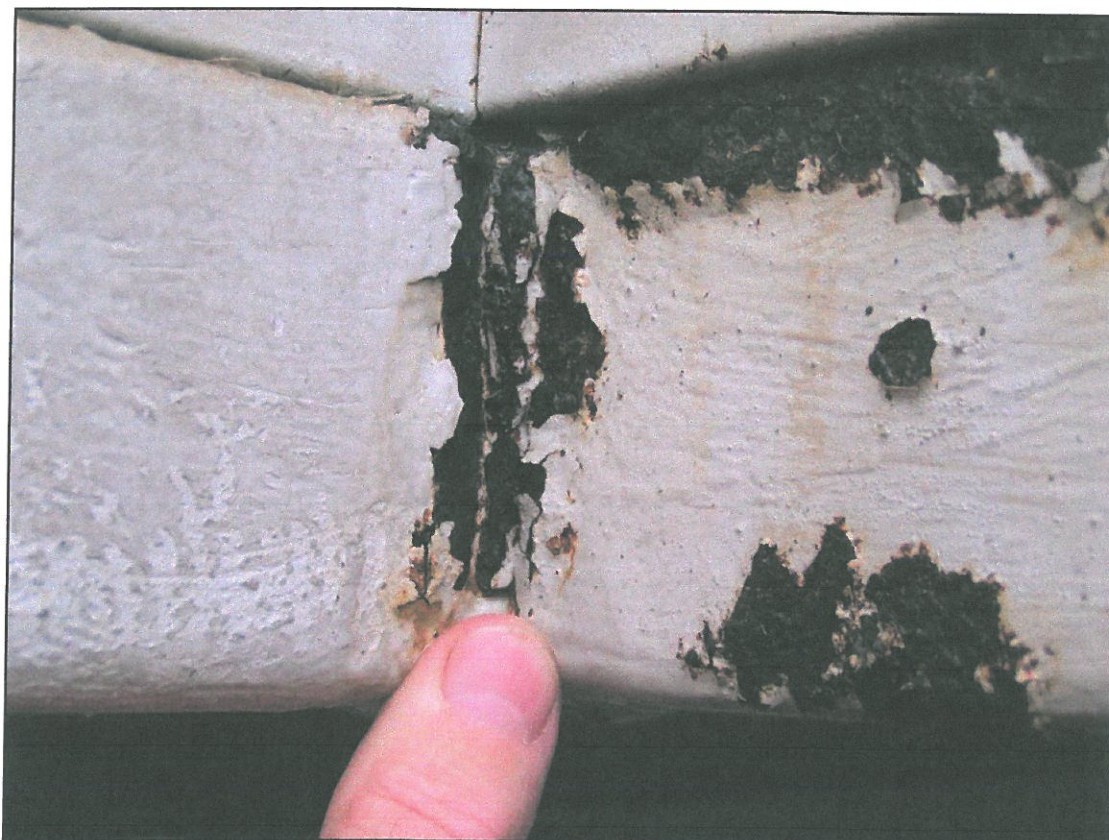
Rys. 11. Zanikająca warstwa farby antykorozyjnej w obszarze belki sufitowej.
