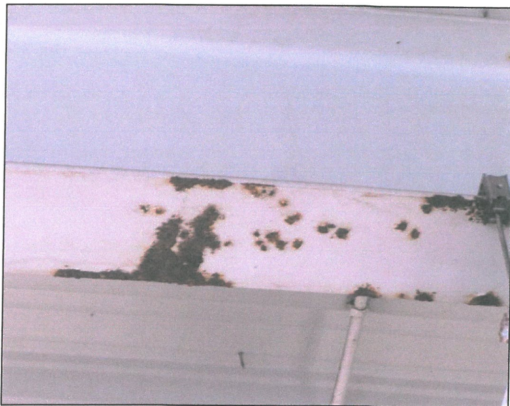
Rys.6. Korozja miejscowa na powierzchni rygli dachowych.
