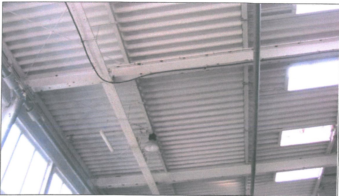
Rys. 8. Korozja płatew dachowych.
