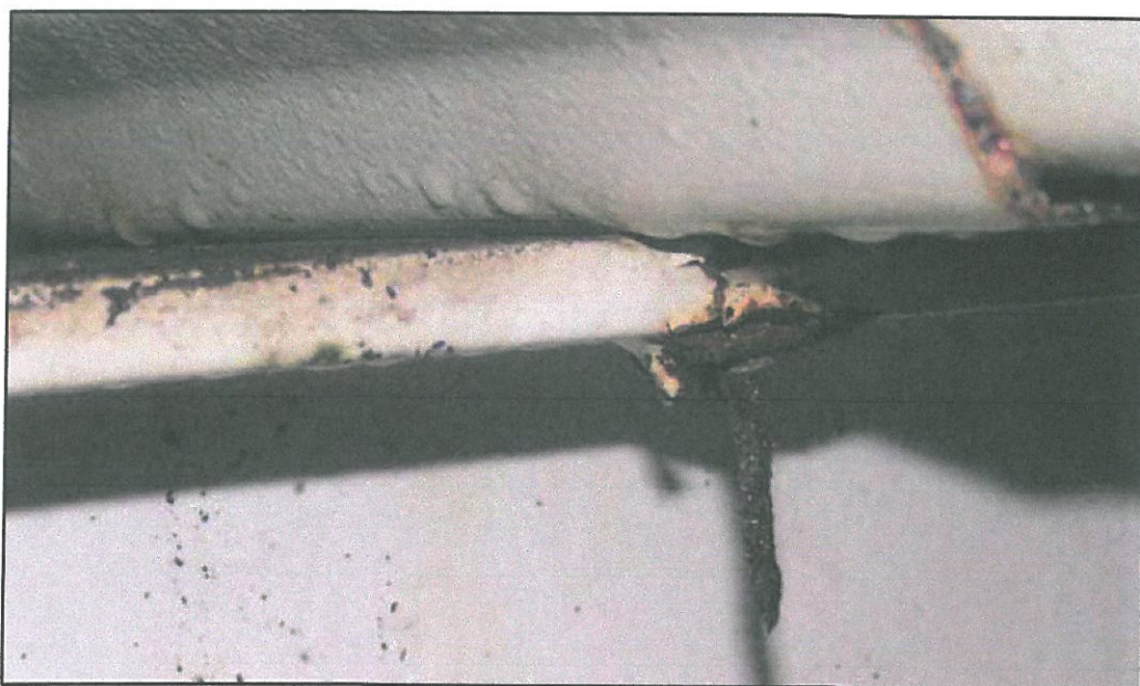
Rys. 8. Zły stan niektórych łączników blachy trapezowej z płatwami spowodowany korozją. Łącznik zamocowany zbyt blisko krawędzi górnej półki płatwi. Wątpliwie zabezpieczenie płatwi przed utratą stabilności.
