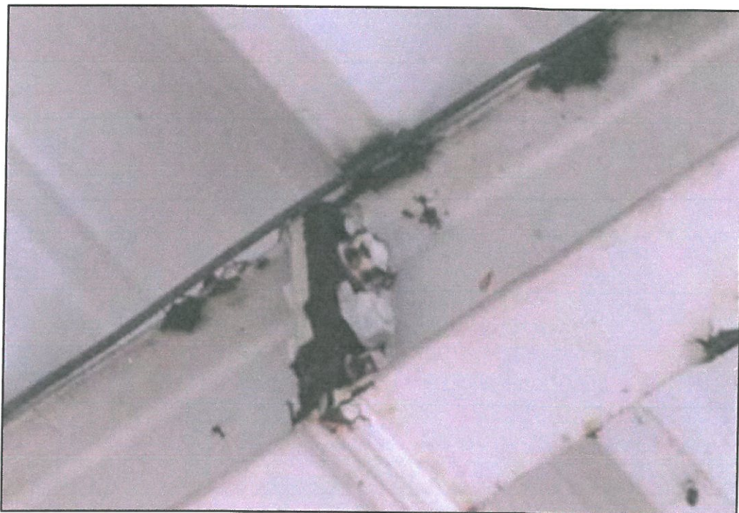
Rys. 11. Szybko postępująca korozja blachy czołowej i łączników w połączeniu uciągającym płatwie dachowe.
