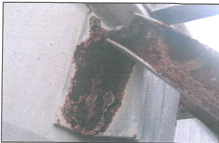
Rys.13 Skorodowany w znacznym stopniu element wsporczy klap dymowych (wyposażenie hali).
