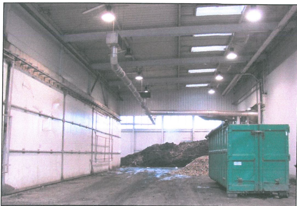
Rys.2 Widok ustroju konstrukcyjnego hali 6d.3 oraz składowanej biomasy, która wyraźnie paruje drzwi zewnętrzne do hali otwarte,
