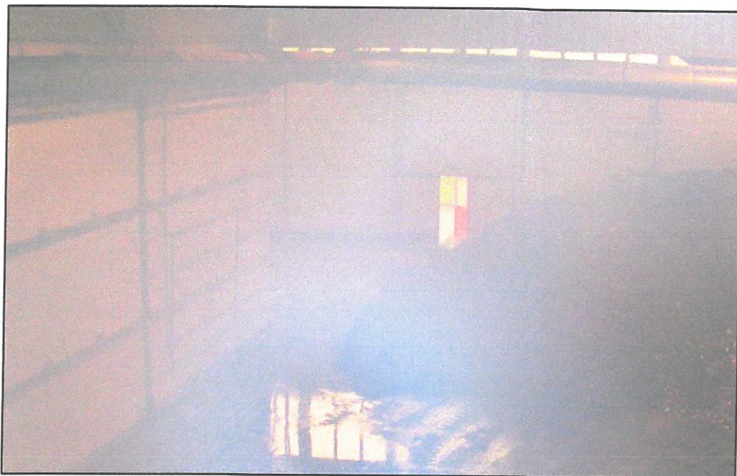
Rys.3. Widok ustroju konstrukcyjnego hali 6d.3 oraz składowanej biomasy, która wyraźnie paruje drzwi zewnętrzne do hali zamknięte
