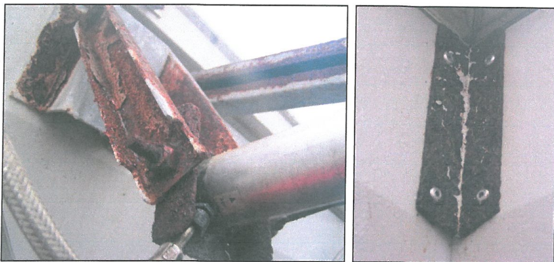
Rys. 4. Korozja blach ocynkowanych użytych na elementy dodatkowe.
