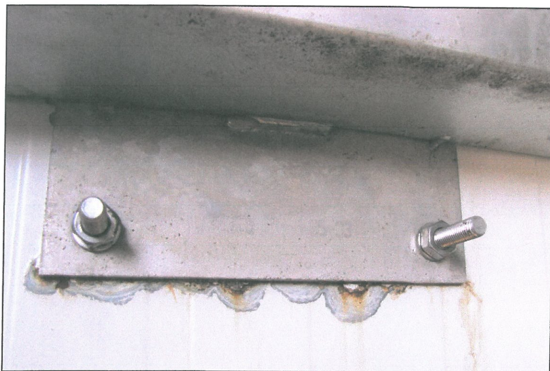
Rys. 7. Korozja blach mocujących bramy.
