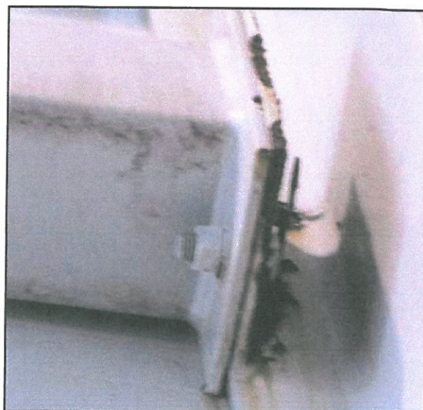
Rys. 12. Zły stan blach węzłowych połączeń poziomych elementów ściennych.
