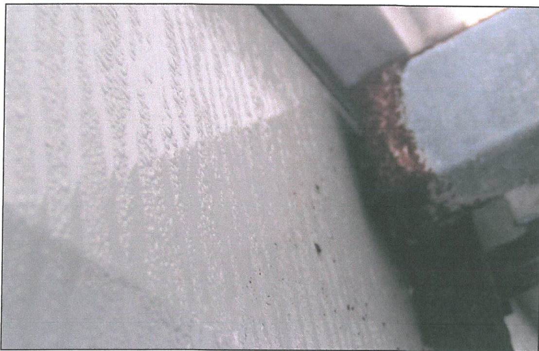
Rys. 13. Wykropliny na powierzchni ścian hali.
