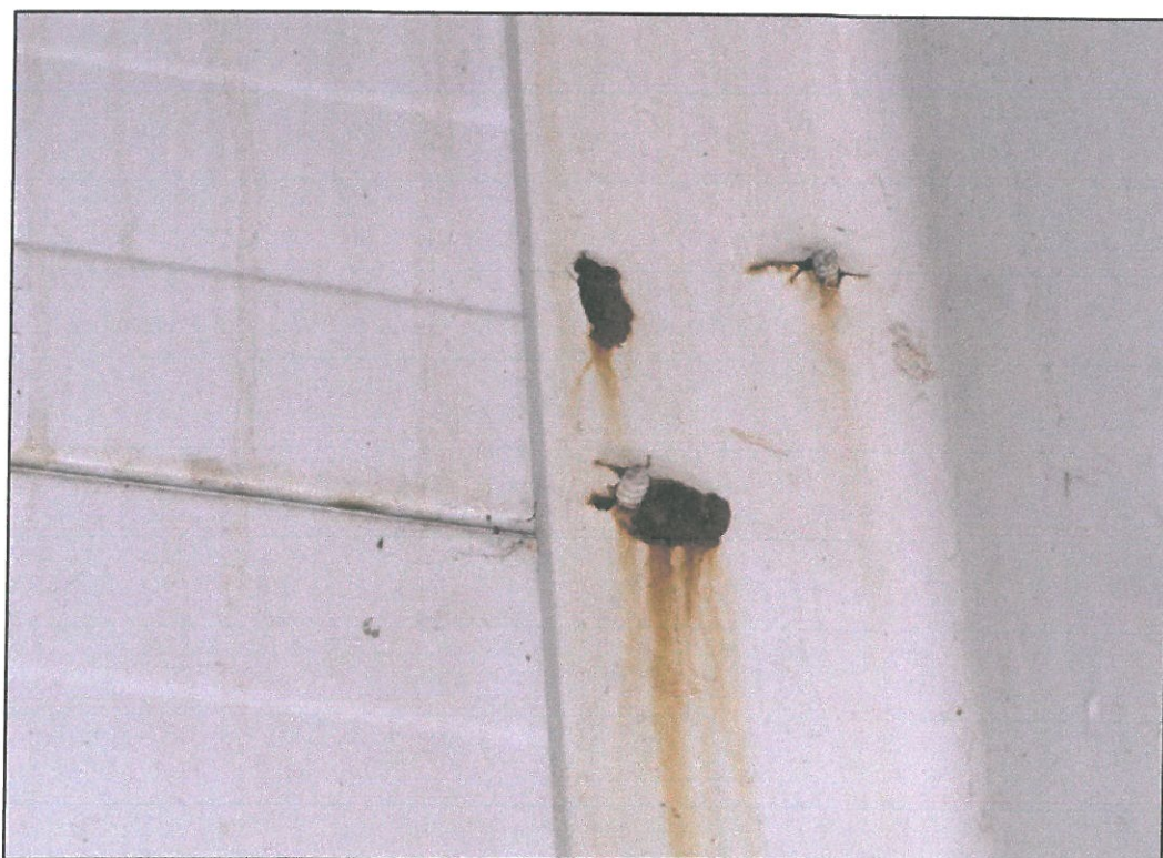
Rys. 3. Uszkodzenia korozyjne w miejscach mocowania kołków do ściany - rdza
