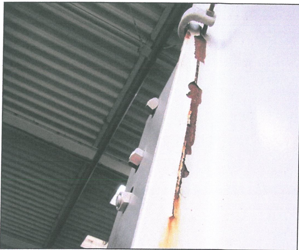
Rys. 2. Mocowanie skrzynki elektrycznej (ślady przesuwania skrzynki-korozja).
